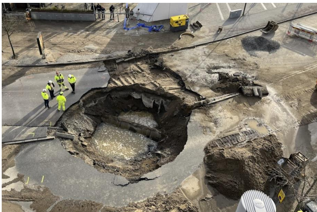
Figur 3: Lokal konsekvens av en brusten huvudvattenledning, Jönköping 2025
